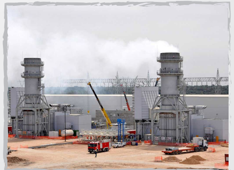
Nainawa Gas Turbines (6x125 MW) 9E
